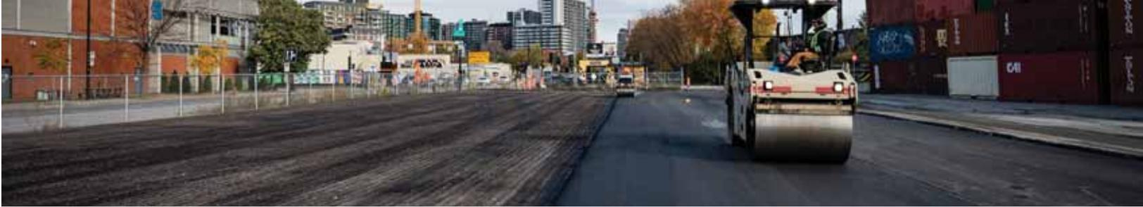
Une structure de chaussée doit permettre la circulation des véhicules dans les meilleures conditions et répartir les sollicitations pour supporter sans dommage les efforts mécaniques engendrés. Des couches d'assise de haute performance sont donc requises pour la construction d'infrastructures soumises à des trafics lourds et intensifs.
