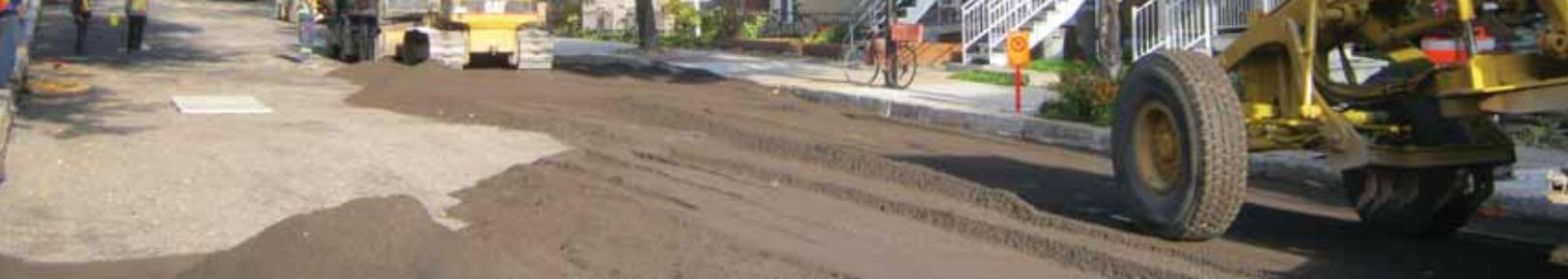
Principalement utilisé comme couche de base ou de fondation, le Recyflex® est un procédé qui consiste à traiter en usine des granulats neufs ou récupérés des particules d'enrobés bitumineux issues du fraisage du béton concassé, en y incorporant un liant composite. La formule est adaptée selon le type de chaussée, la nature des fondations en place ou encore le volume de trafic.
